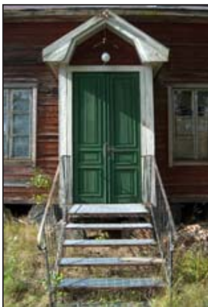
Fig 24. Entré till kontors- och förrådsbyggnad. Foto: Mattias Ek 2005. Bildbeteckning: Lx2005-1593.
