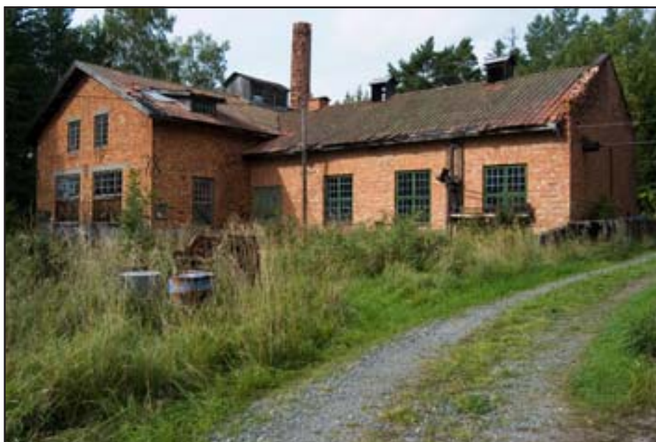
Fig 10. Smedjan från sydost. Foto: Mattias Ek 2005. Bildbeteckning Lx2005-1575.
