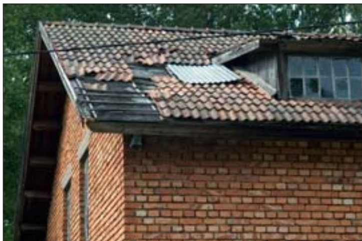
Fig 55. Norra takfallet, smedjan, buskropp A. Tegelpannor saknas i östra hörnet. Foto: Mattias Ek 2005. Bildbeteckning: Lx2005-1578.
