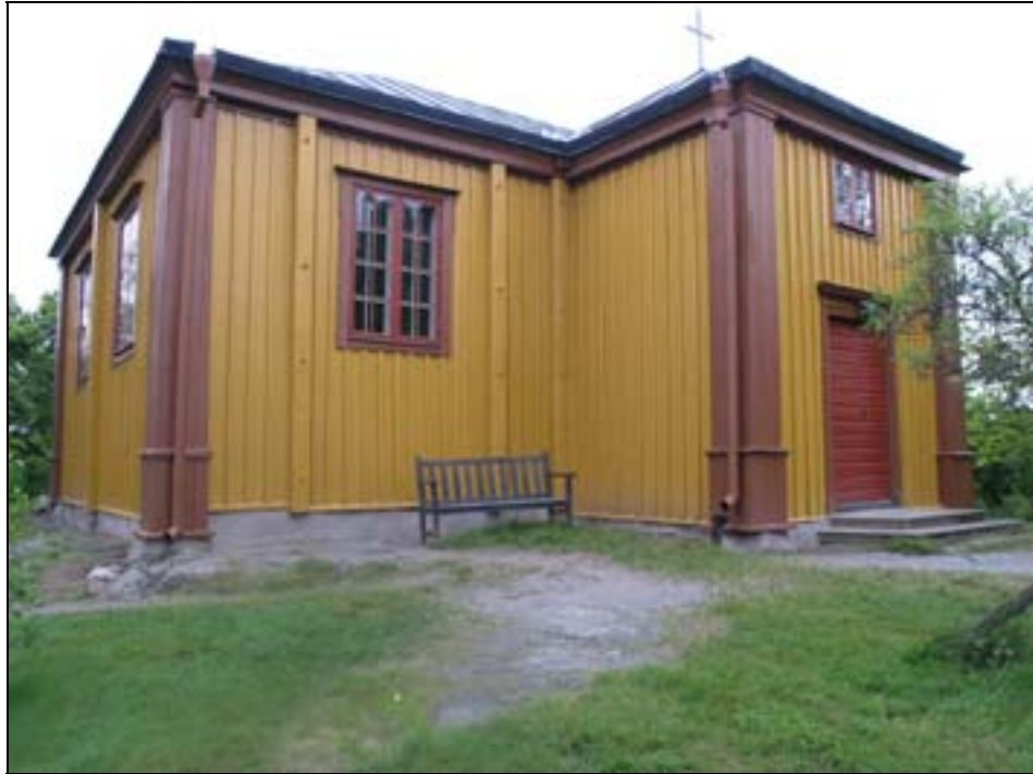
Kapellet efter att arbetena har slutförts. Foto: Kersti Lilja 2005. Bildbeteckning: Lp2005-0901.
