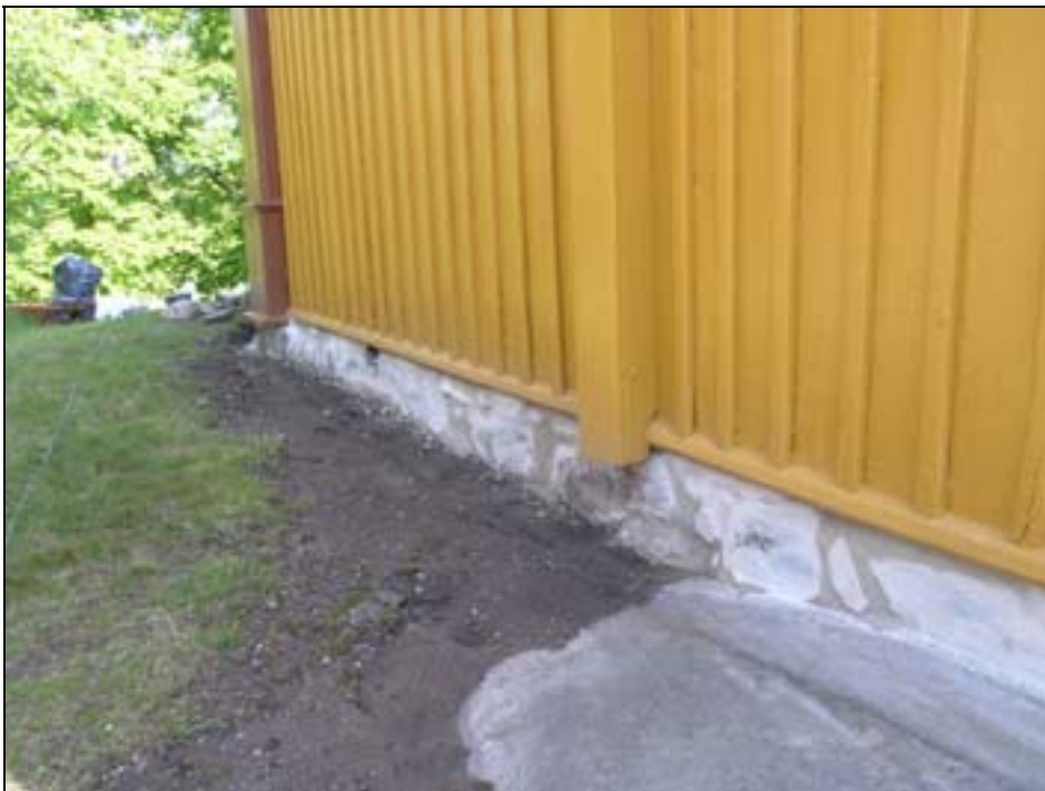
Sockeln efter fogning med hydrauliskt kalkbruk. Foto: Kersti Lilja. Bildbeteckning: Lp2005-0900.
