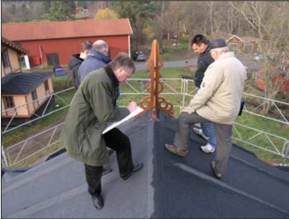
Bildbeteckning: Lp2005-0953. Detaljbild av listtäckning och den västra takspiran. Foto Kersti Lilja 2005.
