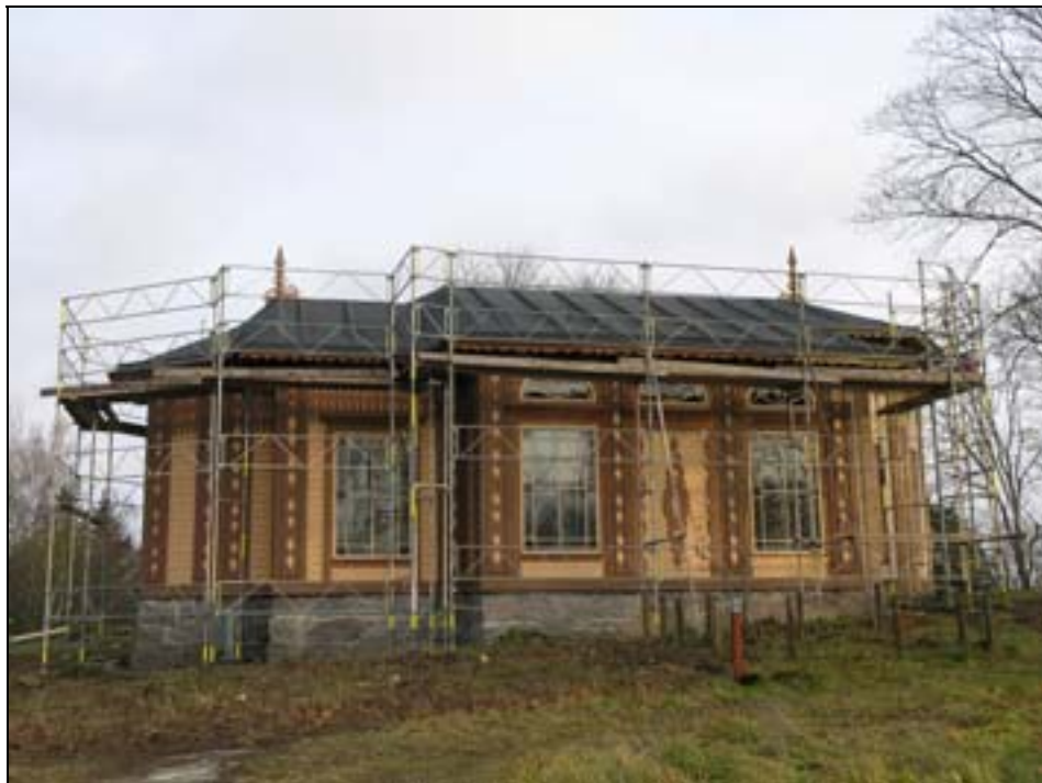
Bildbeteckning: Lp2005-0952. Kapellet från söder efter arbetena. Foto: Kersti Lilja 2005.
