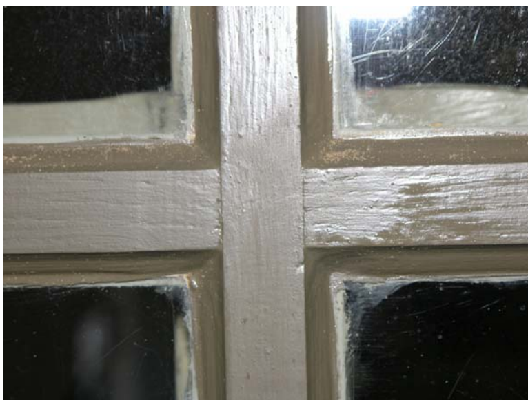
Del av nymålade båge i korfönstret. Foto: Lisa Sundström, augusti 2005.
