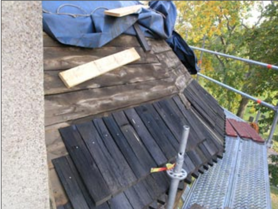
Bildbeteckning: lp2005-1472. Detaljbild under arbetena med spåntäckning av kortaket. Foto Kersti Lilja 2005.
