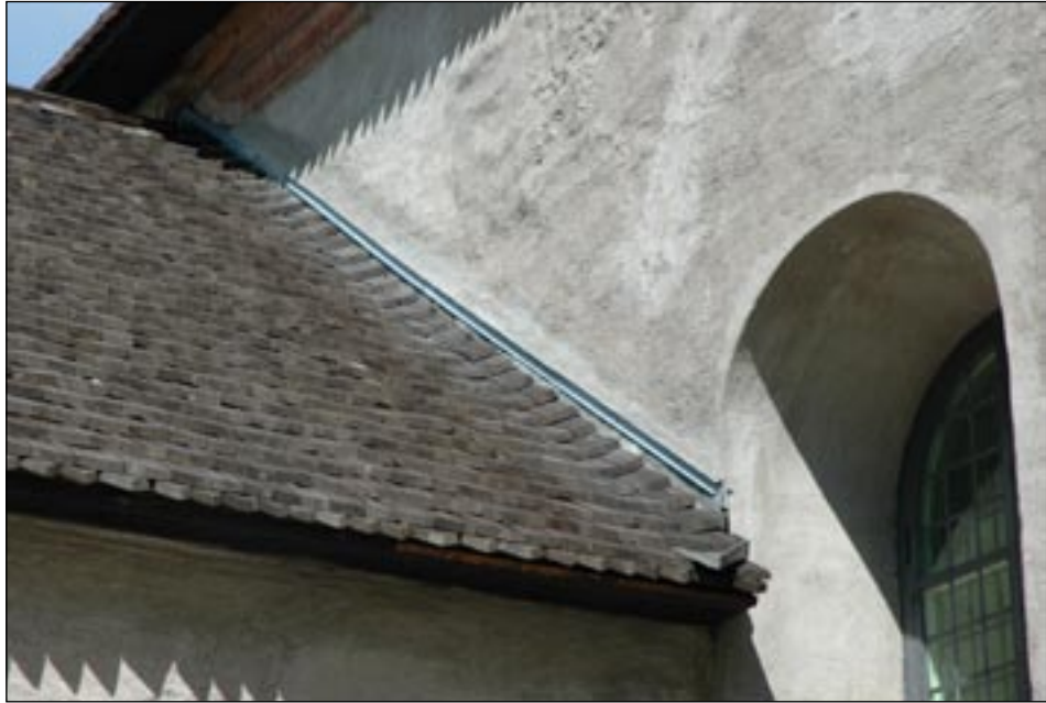
Bildbeteckning: lp2005-1474. Vapenbusets östra takfall efter arbetena. Foto Kersti Lilja 2006.
