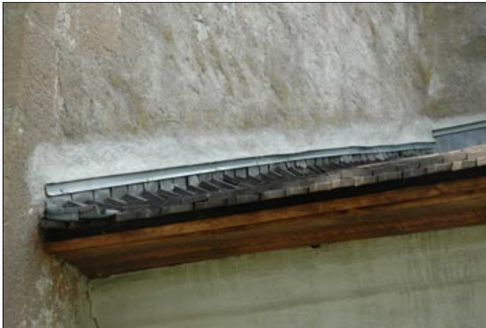
Bildbeteckning: lp2005-1475. Detaljbild av plåtskoning mellan sakristians östra takfall och tornets norra fasad. Foto Kersti Lilja 2006.
