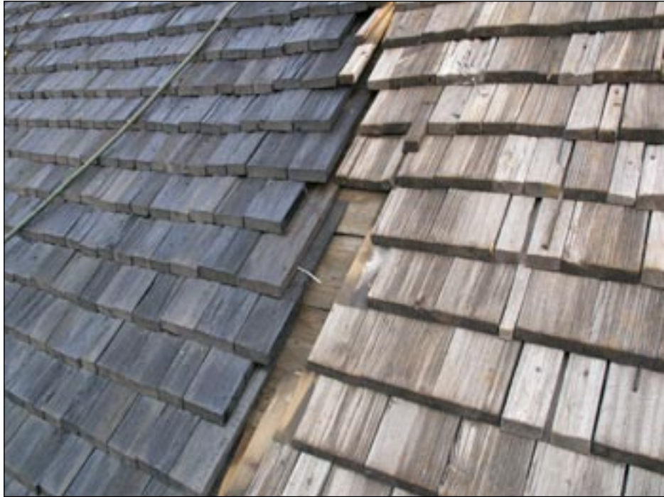
Bildbeteckning: lp2005-1470. Spånläggning på kyrkans södra takfall. Nytt furuspån till vänster och gammalt till höger. Foto Kersti Lilja 2005.
