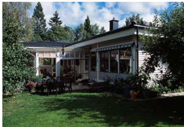
En vinkeltillbyggnad skapar en skyddad plats mellan de två huskropparna. Foto Elisabeth Boogh
