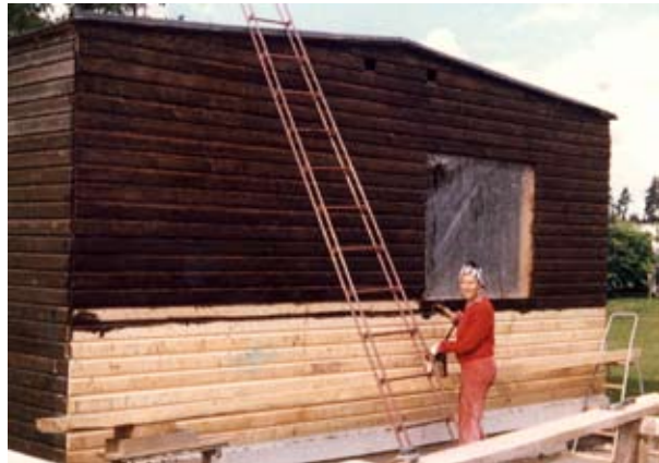
Tillbyggnaden målas. Den nya delen har likadan panel och samma typ av färg som det ursprungliga huset. Foto familjen Arvidsson.
