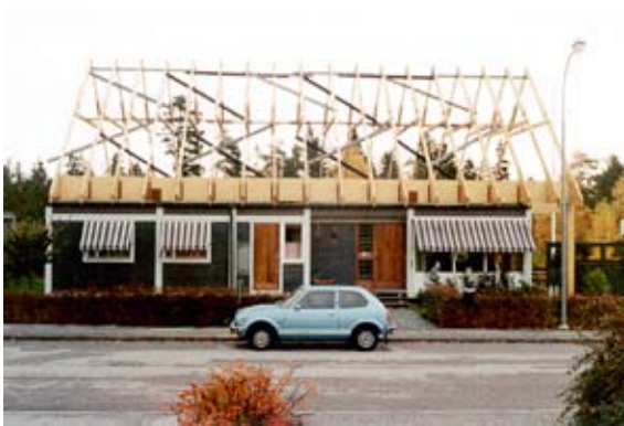
I början av 1976 byggde Olle Källhammar på en övervåning på familjens villa. Foto familjen Källhammar.
