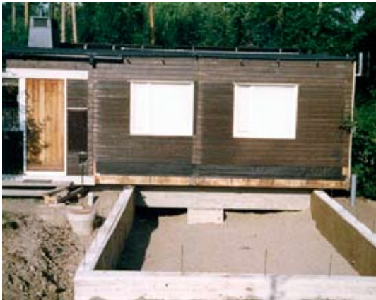
En tillbyggnad växer fram. Grunden är gjuten och klar. Foto familjen Arvidsson
