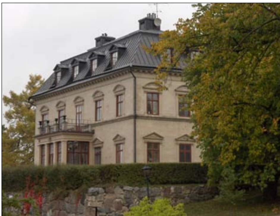
Görvälns slott efter upprustningsarbeten, bildnr: lp20060382.
