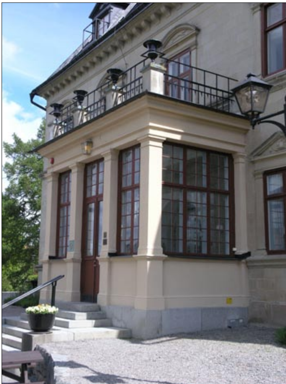
Veranda med ovanliggande balkong med räcke av smide och urnor av gjutjärn, bildnr: lp20060384. Foto: Lisa Sundström, 2006.
