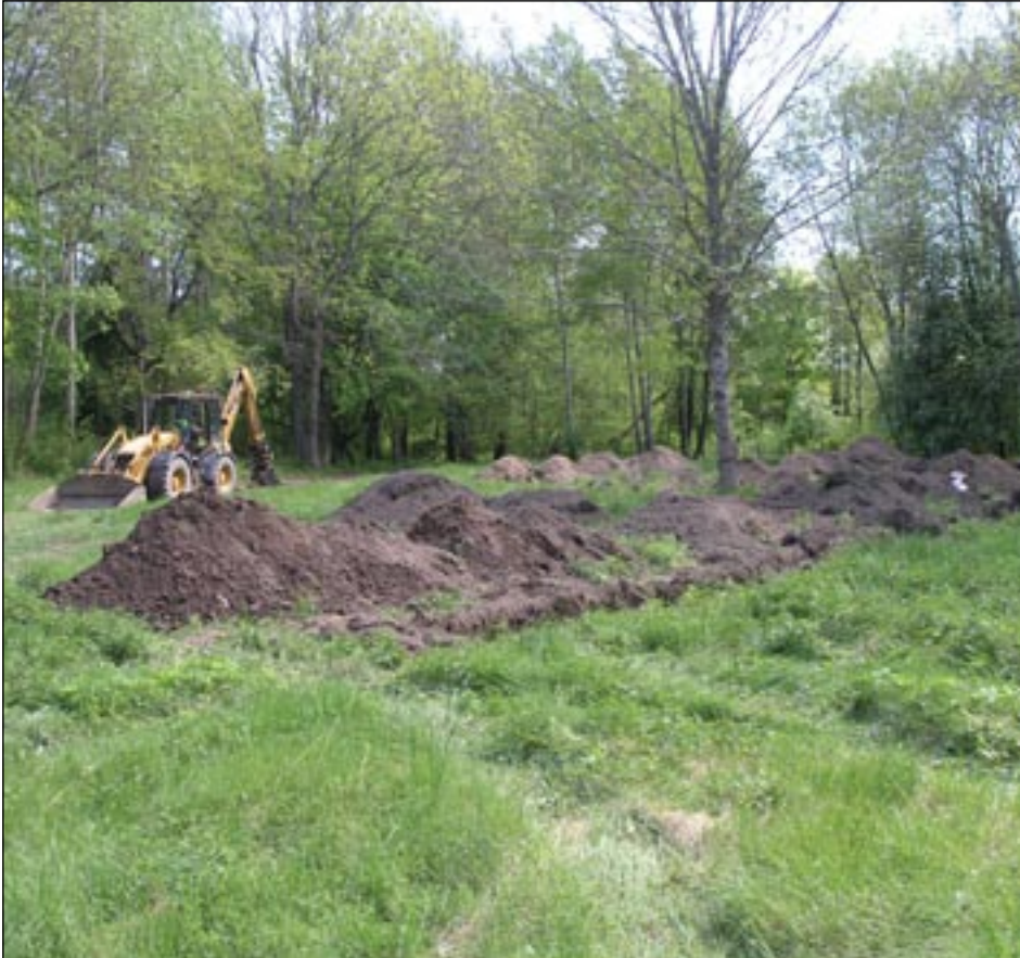
Fig 3. Schaktning i Ribbys nordliga del.
