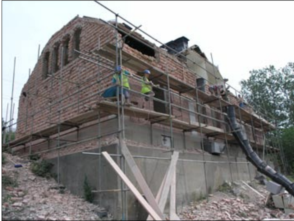
Stationshusets stomme efter demontering av byggnadsdelar och fasadtegel. Bilden är tagen från nordväst. Bildbeteckning: lp200514-94.
