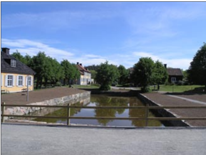
Staket intill dammens västra kortsida. Foto: L. Sundström. Bildnr: lp20060377
