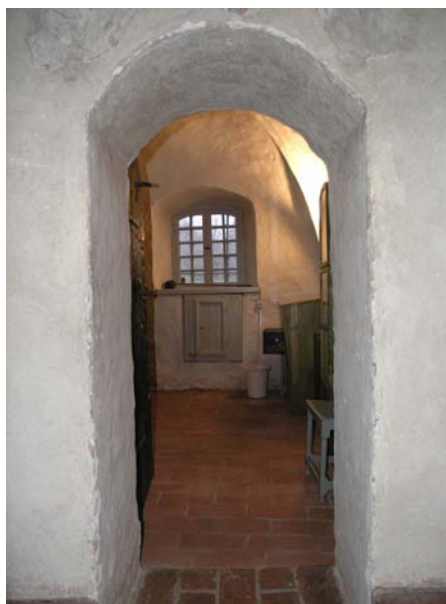
Nytt tegelgolv i sakristian.
