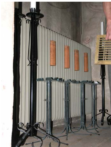
Äldre flänsradiator bakom predikstol. Bildnummer: lp20051357
