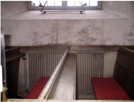
Äldre flänsradiator i s. långhusväggen. Igenmurad nisch i n. långhusväggen. Bildnummer: lp20051362
