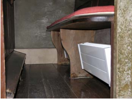
Nya konvektorer samt ledningar inbyggda i låda vid långhusväggarna. Bildnummer: lp20051361
