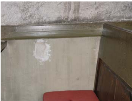
List och del av bänkinredningen har kompletterats lika befintligt vid de igenmurade nischerna i s. och n. långhusväggarna. Bildnummer: lp20051364
