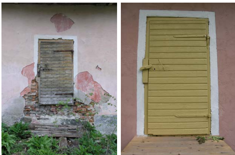
Entrédörr åt söder före och efter upprustning och målning. Bildnr: lp20051383 till vänster. Bildnr: lp20051384 till höger. Foto: L. Sundström, 2005.
