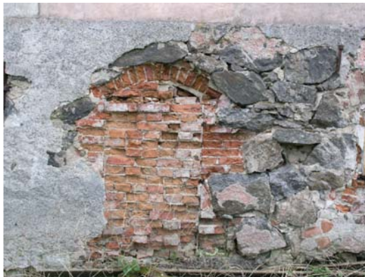
Spår efter igensatt öppning souterrain åt n. Bildnr: lp20051376. Foto: L. Sundström, 2005.
