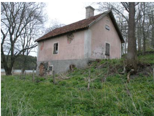
Mejeriet åt n. före renovering. Bildnr: lp20051374. Foto: L. Sundström, 2005.
