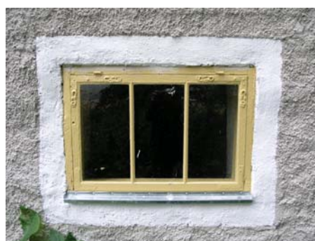
Fönster i källarvåning mot öst. Karmbottenstycket har kompletterats och bågen har kompletteringslagats i nedre delen samt ny spröjsning. Bågens rikt utformade fönsterbeslagning renoverades och återanvändes. Bildnr: lp20051381 till vänster. Bildnr: lp20051382 till höger. Foto: L. Sundström, 2005.
