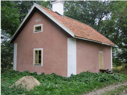
Mejeriet från s-v efter renovering. Bildnr: lp20051377. Foto: L. Sundström, September 2005.
