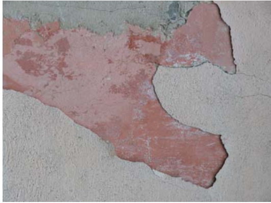
Under nuvarande yttre putsskikt finns en kraftigare rosa avfärgning. Bildnr: lp20051375. Foto: L. Sundström, 2005.
