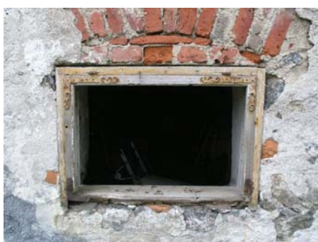
Fönster i källarvåning mot öst. Karmbottenstycket har kompletterats och bågen har kompletteringslagats i nedre delen samt ny spröjsning. Bågens rikt utformade fönsterbeslagning renoverades och återanvändes. Bildnr: lp20051381 till vänster. Bildnr: lp20051382 till höger. Foto: L. Sundström, 2005.
