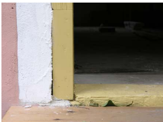
Skarvning av dörrkarm åt söder. Bildnr: lp20051385. Foto: L. Sundström, 2005.
