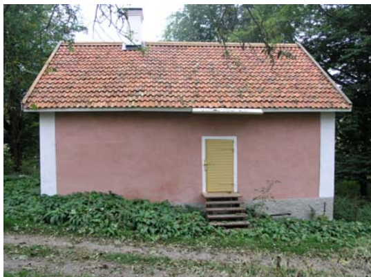
Mejeriet från söder. Ny trappa och hängränna av trä över entrédörr nytillverkades och tjärades. Bildnr: lp20051389. Foto: L. Sundström, 2005.
