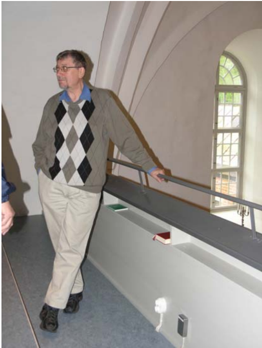
Läktarbarriären har kompletterats med säkerhetsräcke. Foto: Lisa Sundström, 2005-06-03. Bildnr: lp20051420
