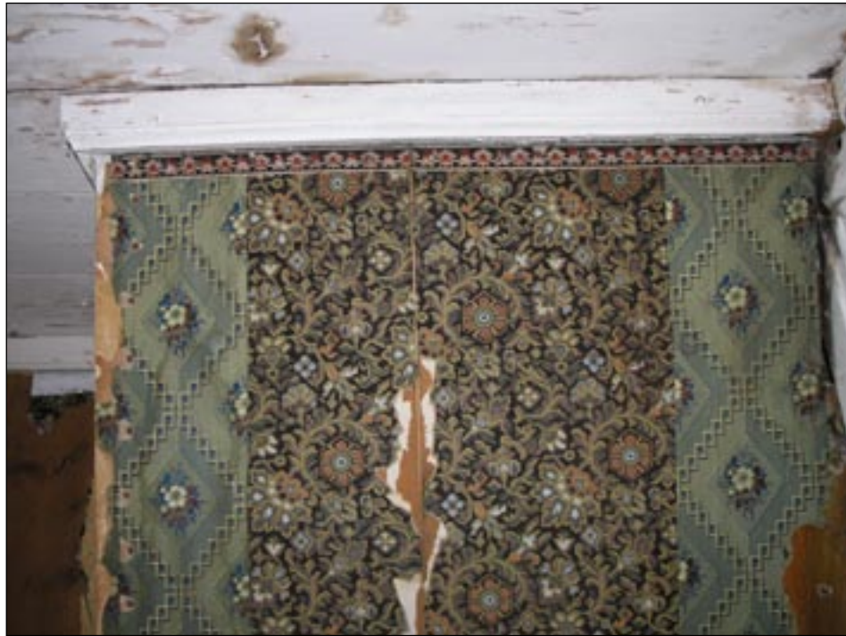
Bildbeteckning: lp2005-1464. Två olika tapeter, uppsatta vid samma tidpunkt, vid sidan av varandra och med samma bård mot taklisten, rum 2. Foto: Kersti Lilja 2006.
