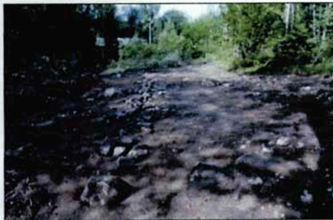
Fig 4. Framrensad terrasskant, foto från S. Foto Örjan Matsson, ssm nr lp2009377.
